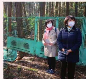
八王子スポーツパーク建設事業(川町)の現場を視察 右がアオヤギ、隣は尾崎都議
