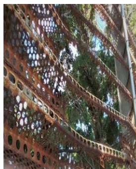
防風柵改修前
