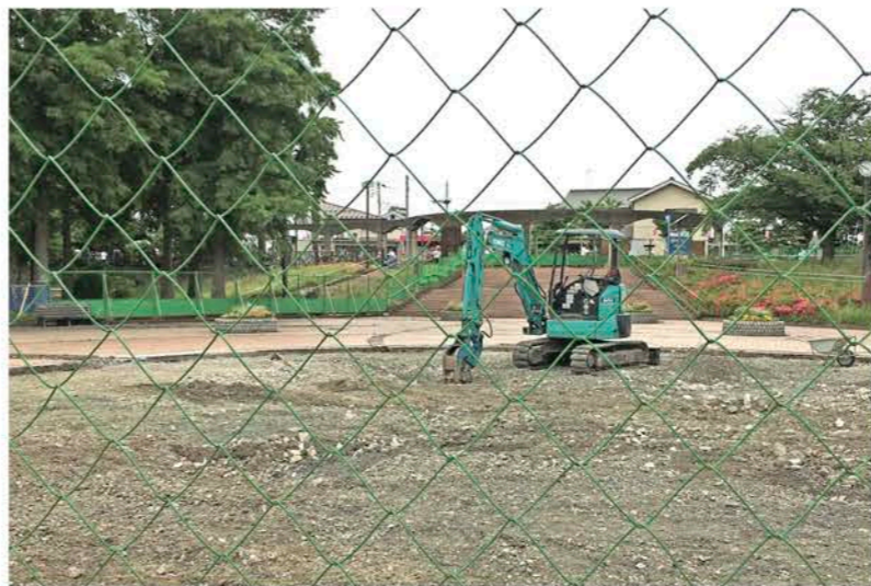
工事が進められている水元公園の噴水広場
