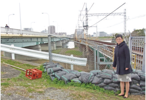
荒川橋梁（堀切橋の下を鉄橋が）
