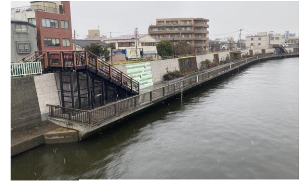
耐震対策後（中川）
