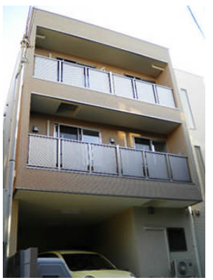
写真は2011年12月に開設された世田谷で第1号の軽費老人ホーム「ケアハウス赤堤」
